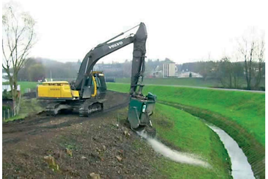
Stubbenfräse am Bagger
