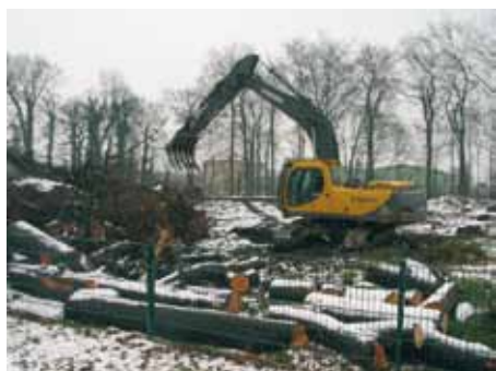
Volvo-koparka z karczownikiem Do oddzielania ziemi od korzeni
